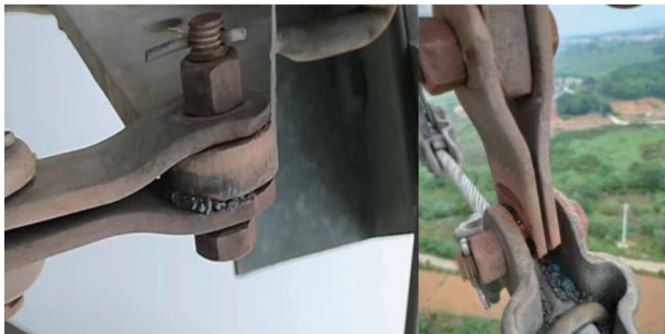
图 3 103 号铁塔左侧地线联板照片
