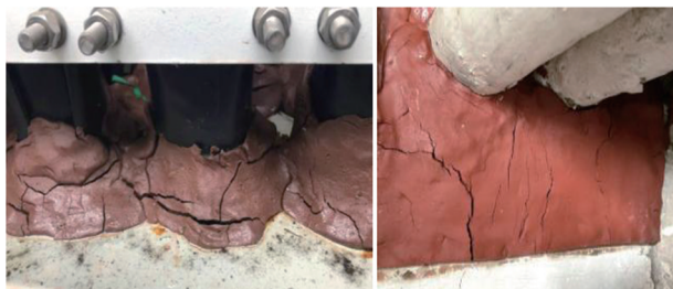
图 4 某变电站内有机封堵材料的现场照片
