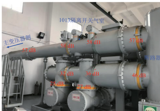
图 2 各盆式绝缘子处异常特高频信号幅值分布
