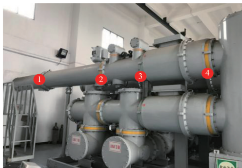
图 4 时差定位传感器布置
