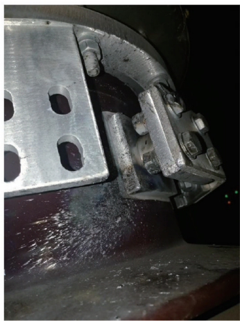
图3 103电流互感器P1端接线座放电痕迹
