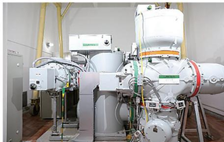
图7 安装完成的 110 kV C<sub>4</sub>F<sub>7</sub>N 环保气体 GIS 完整间隔
