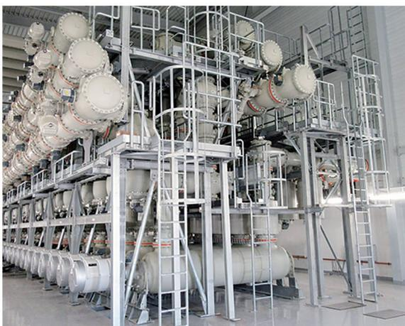
图 2 ABB 公司的环保型 380 kV GIS 安装在德国 TransnetBW 公司的 Weier 变电站
