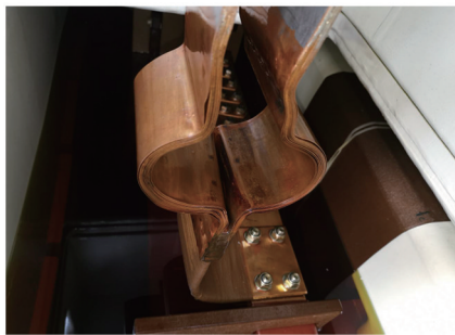
图 6 低压绕组接头无松动、发热痕迹
