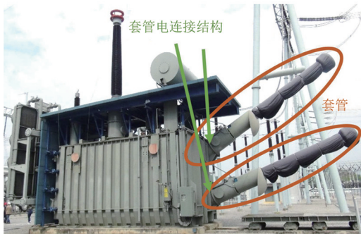
图 1 变压器套管电连接结构
