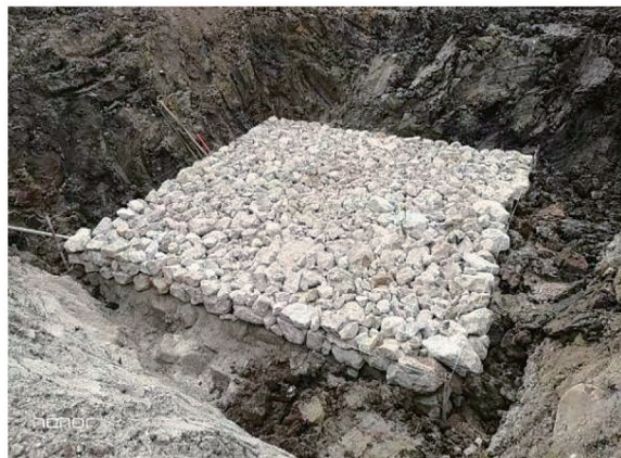
图7 浆砌块石反压施工现场
