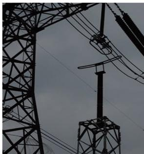
(e)  $\pm 500$  kV 单回直流线路立塔式安装
