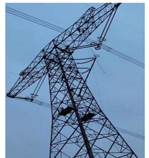
(f)  $\pm 800$  kV 直流线路复合绝缘子斜拉式安装
