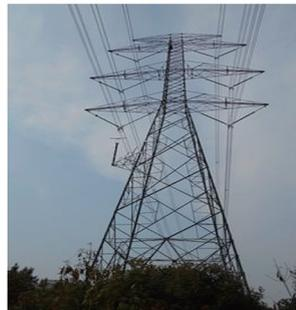
(d) 500 kV 同塔双回交流线路座式安装
