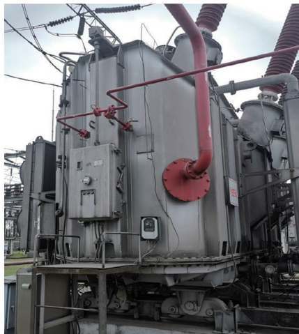
图 2 采用人孔和取样阀方式
