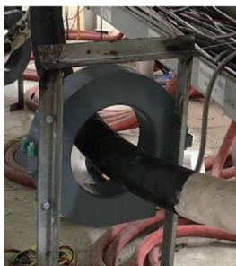
图 4 零序光学电流互感器现场安装
