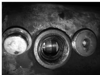
图3 C相套管解体
