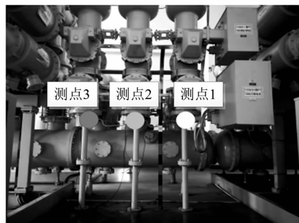
图 4 轴向定位特高频测点布置
