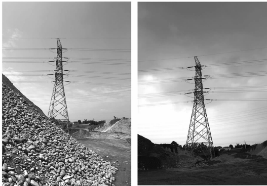
图1 220 kV 桃圣线 M 号塔
