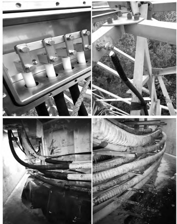
图7 烧损电缆故障恢复
