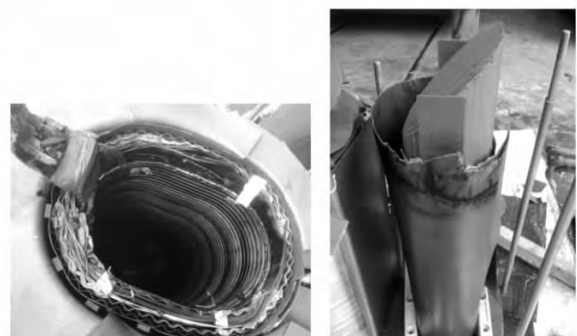
(a) (b) 图2 10号变压器A相解体情况
