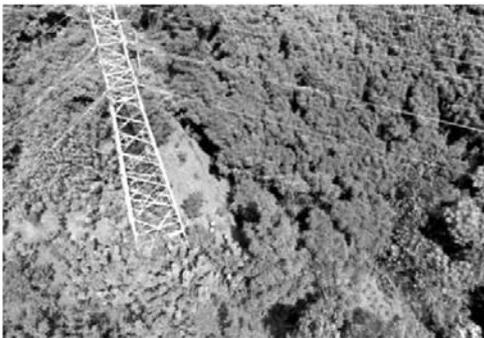
图4 110 kV某线路区域发生山体滑坡
