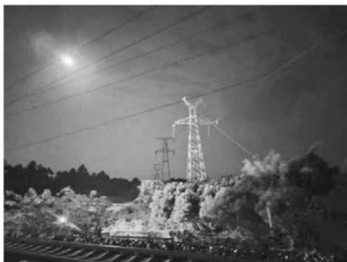
图5 220 kV某线路夜间更换架空地线
