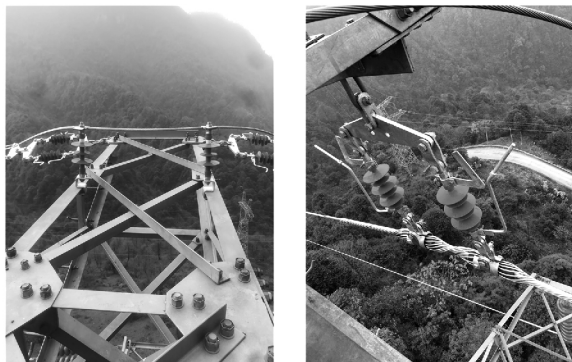
(a)耐张串地线绝缘子 (b)悬垂串地线绝缘子
