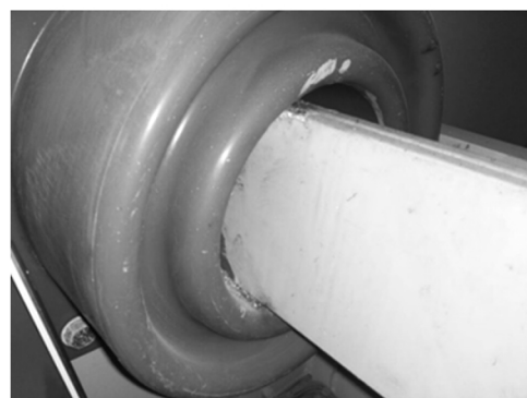
图9 9022隔离柜穿柜套管A相
