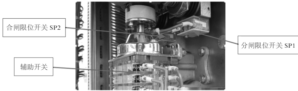
图9 改造前隔离开关操作机构
