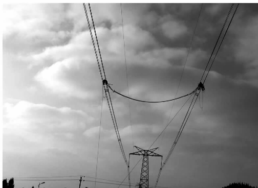
图3 极间间隔棒在高耸直流的挂网情况
