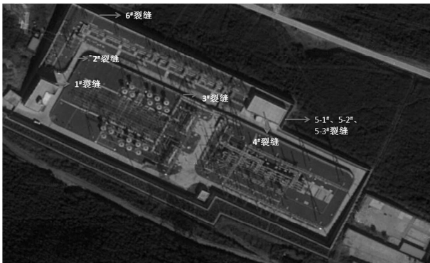
图7 500 kV 变电站沉降裂缝点位置卫星影像图
