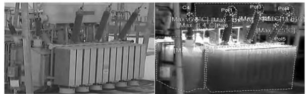
图5 双视监控器中变压器的现场图像
