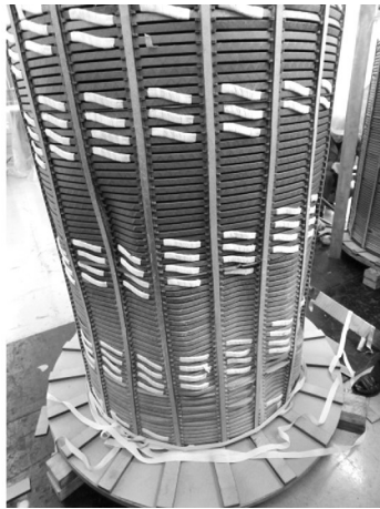
图 8 吊心检查中压 B 相
