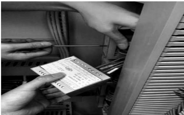
图 9 更换电压采集模块现场照片
