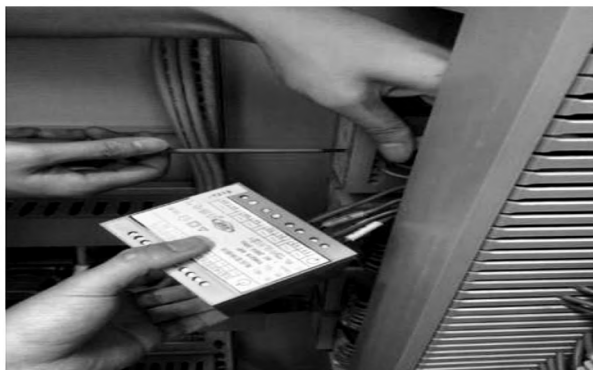
图 9 更换电压采集模块现场照片
