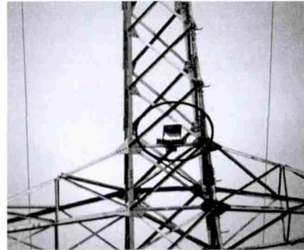
图6 智能超声驱鸟装置现场安装照片
