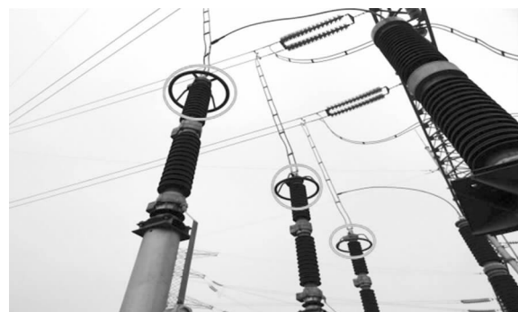
图 9 220 kV 汉音一线 263 出线侧与直流融冰输出电缆连接点
