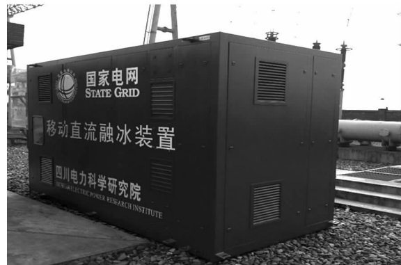
图 7 移动直流融冰装置外观图
