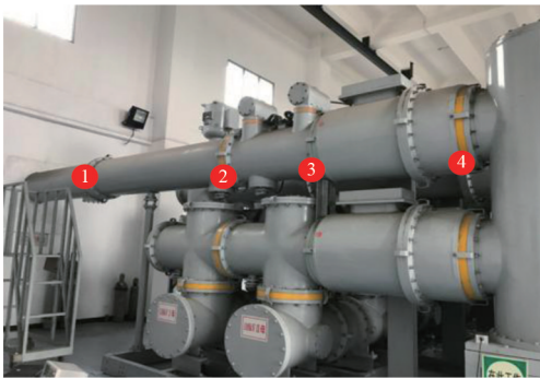
图 4 时差定位传感器布置
