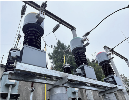
图 9 35 kV 环保型 C 5 F 10 O 混合气体电流互感器示范应用
