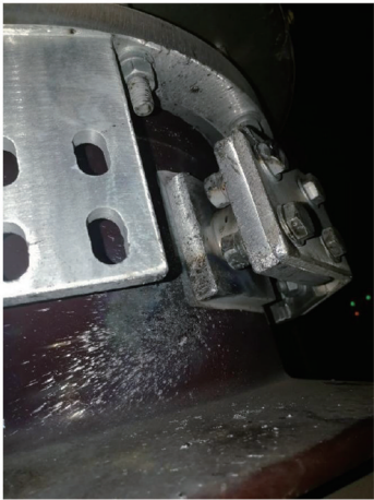
图 3 103 电流互感器 P1 端接线座放电痕迹
