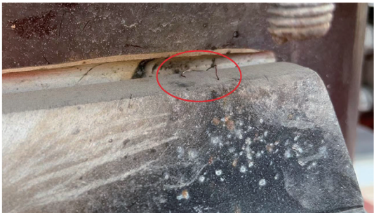
图 8 103 电流互感器 A 相 P1 接线座上残余铜丝
