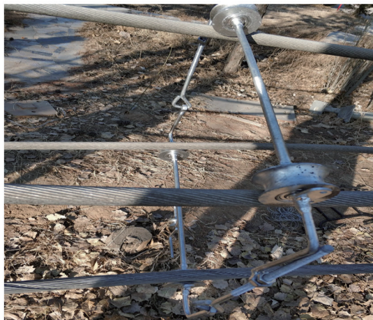
图 8 输电线路导线检修作业平台固定架应用效果
