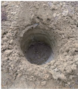
(c) 施工桩孔的质量
