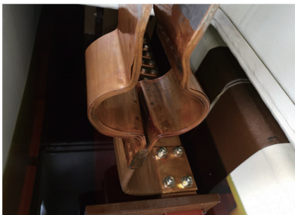
图 6 低压绕组接头无松动、发热痕迹
