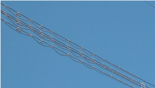
图 5 “β 阻尼线+防振锤”组合设计形式
