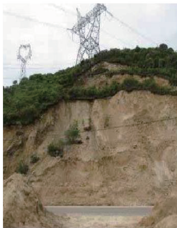
图3 公路切坡诱发滑坡
