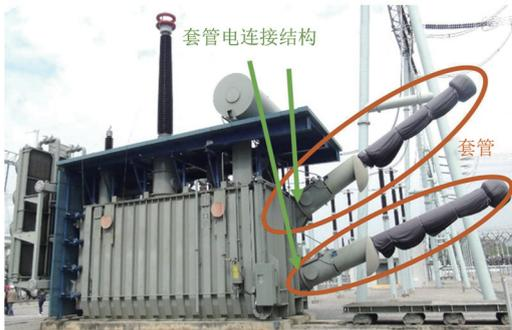
图 1 变压器套管电连接结构
