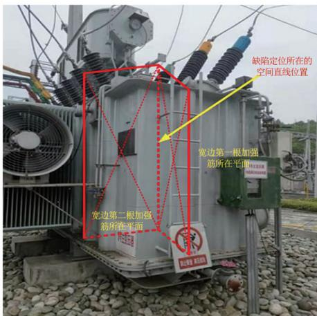
图 14 变压器局部放电缺陷定位结果
