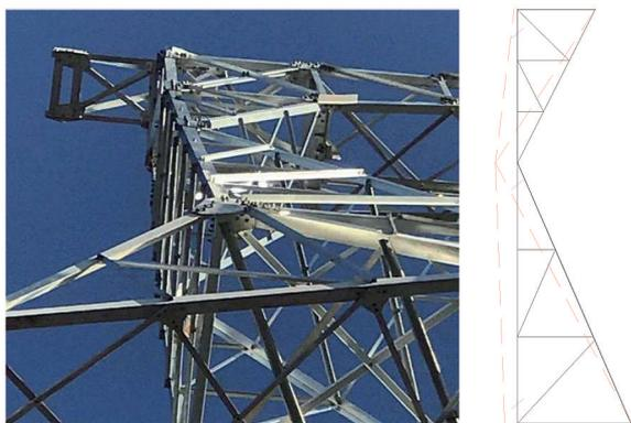
图2 曲臂K节点变形实例及示意图
