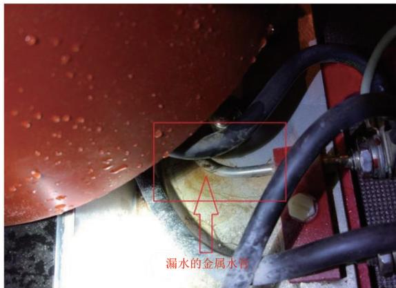
图3 电缆和水管接触磨损缺陷
