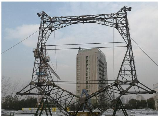
图 15 猫头塔立式试组装现场
