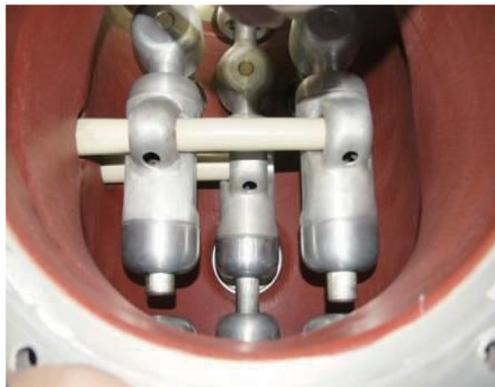
图 4 1813 隔离开关内部
