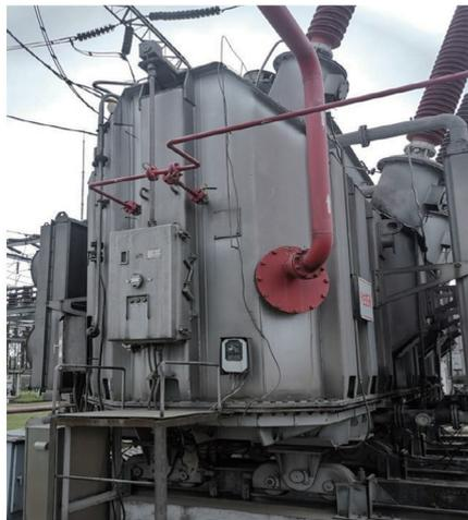
图 2 采用人孔和取样阀方式
