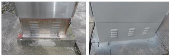
图 5 35 kV 301 断路器间隔防腐处理前后对比
