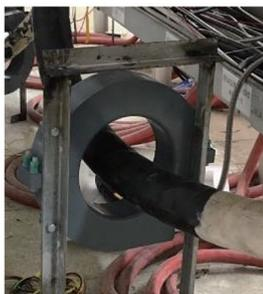
图 4 零序光学电流互感器现场安装
