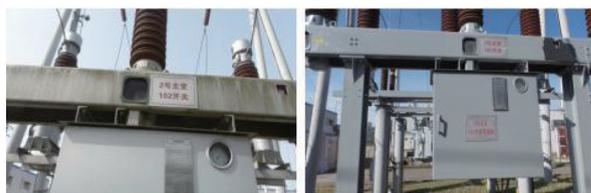
图 4 2 号主变压器 102 断路器支架防腐前后对比
