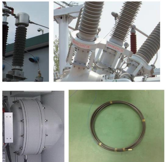
图 2 光学电流互感器安装方式
