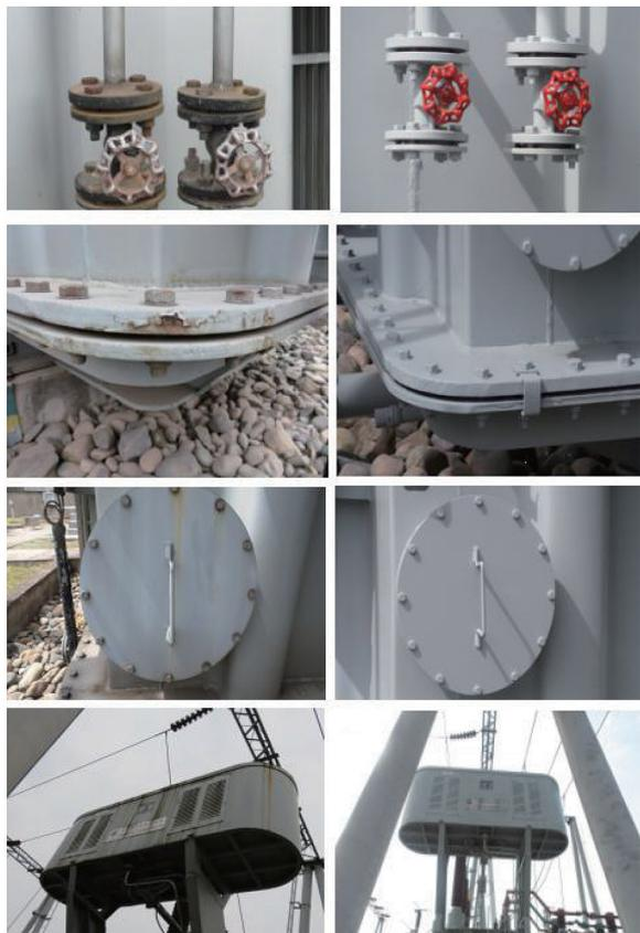
图 3 1 号主变压器本体防腐处理前后对比
