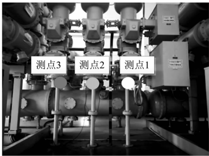
图 4 轴向定位特高频测点布置
