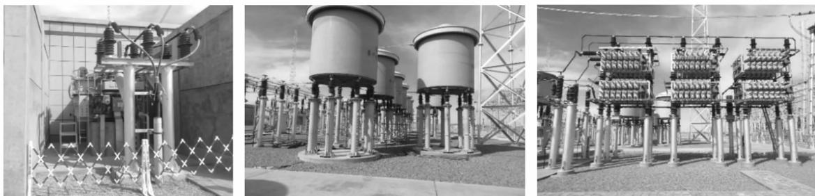
图4 站用变压器、低压电容器和电抗器采用高位布置
