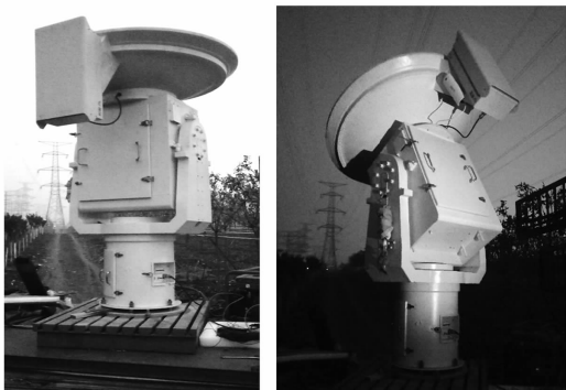
图 6 雷达监测装置现场安装运行
