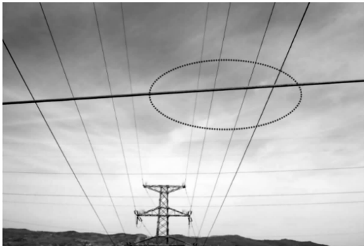
图 11 a、b、e 线放电示意图
