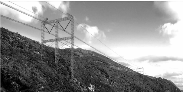
图 3 双极直柱门型塔效果
