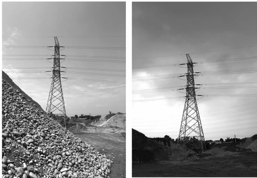
图1 220 kV 桃圣线 M 号塔
