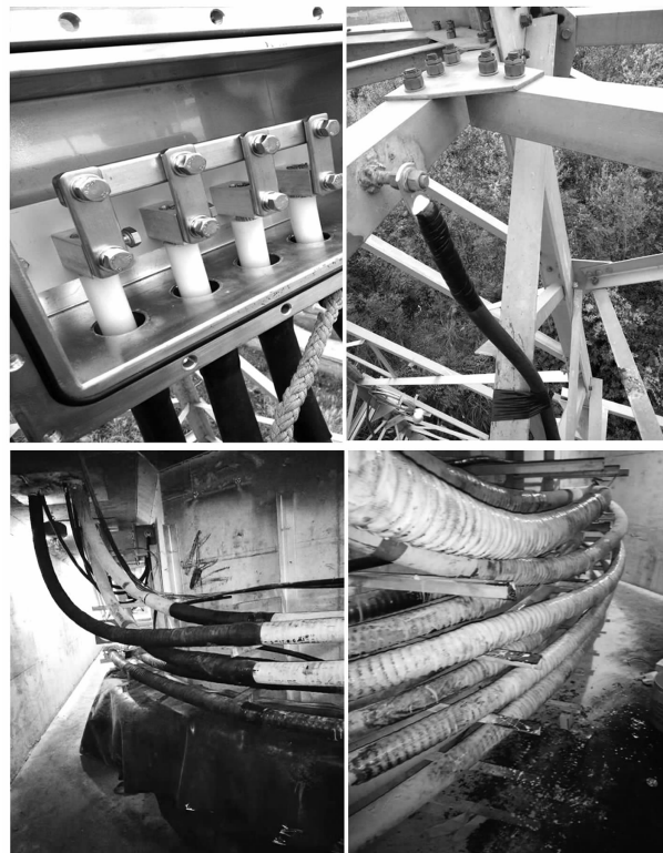
图7 烧损电缆故障恢复
