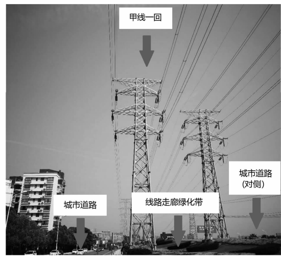
图 7 220 kV 甲线一回 31 号杆塔现场情况
