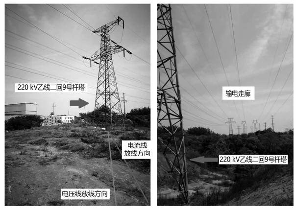
图 8 220 kV 乙线二回 9 号杆塔现场情况 3) 110 kV 丙线 31 号杆塔
