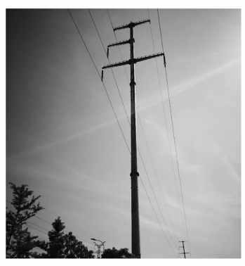
图 9 110 kV 丙线 31 号杆塔现场情况
