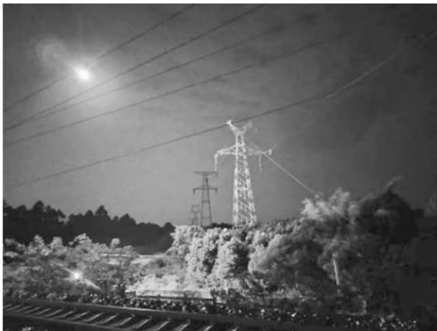
图 5 220 kV 某线路夜间更换架空地线
