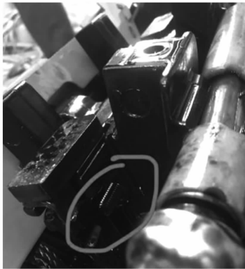
图4 切换开关内部螺栓脱落
