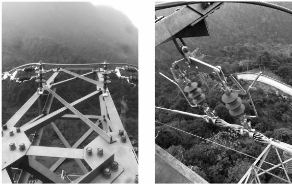
(a)耐张串地线绝缘子 (b)悬垂串地线绝缘子 图4 110 kV 雷坝二线地线绝缘子
