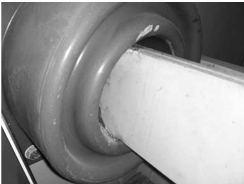
图 9 9022 隔离柜穿柜套管 A 相
