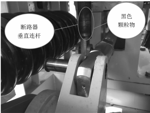
图 3 断路器垂直连杆上的黑色物质
