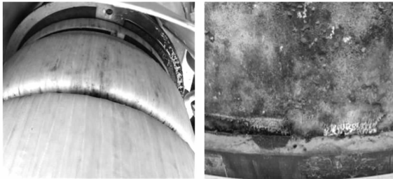
图 1 互感器舱室内部积水及发霉情况
