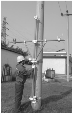
图 11 地面练习安装
