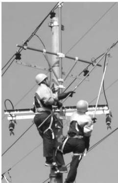
图 12 实际作业现场
