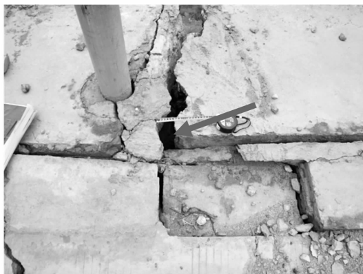
图2 基础开裂
