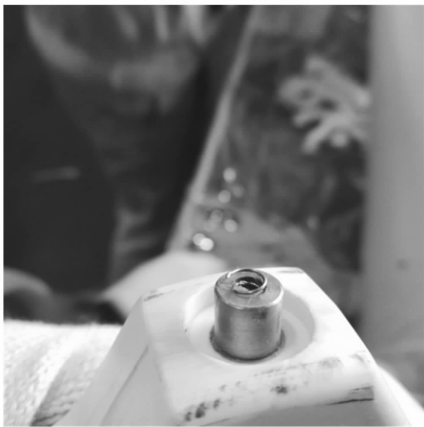
图8 绝缘子支撑螺钉末端金属弹簧安装图 带有弹簧的支撑螺钉安装完成后的现场图见图9。由图可见,由于重力作用,最上端螺钉与筒壁出现了明显间隙。图中圆圈中的金属弹簧张开,保证了螺钉与外壳的金属连接。
