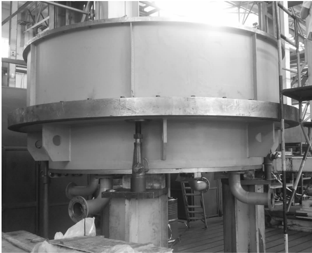
图9 改造后轴承装配厂内预装
