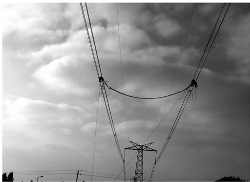
图3 极间间隔棒在高肇直流的挂网情况
