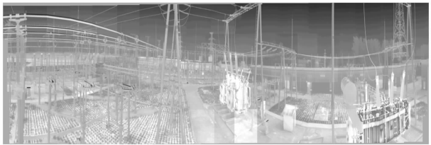
图 6 变电站全景拼接图
